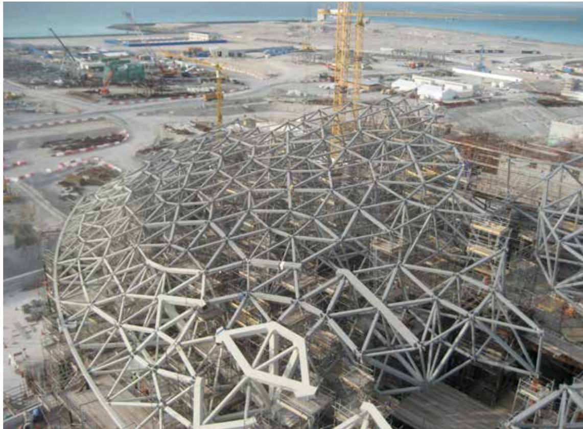
مراحل اجرای سازه‌ی فلزی سقف موزه‌ی لوور در ابوظبی ژان نوول ۲۰۱۷
